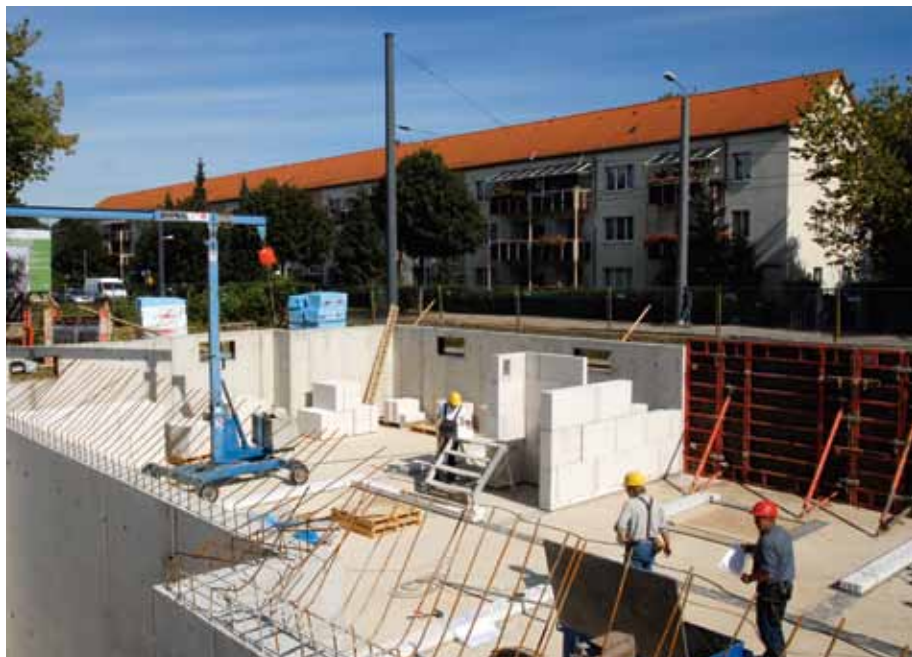
Die Baumaßnahmen in der Christian-Kittel-Straße schreiten voran.
